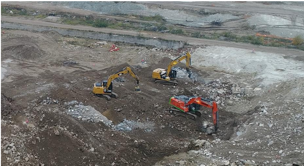
Figure 6 - Atelier de préparation (pince à béton, pelle godet, pelle aimant)
